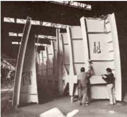
Compuertas en construcción en el establecimiento Cometarsa en Campana, para el complejo hidroeléctrico Salto Grande, 1977. Fuente: Boletín Techint n° 205 (abril-mayo-junio 1977)
